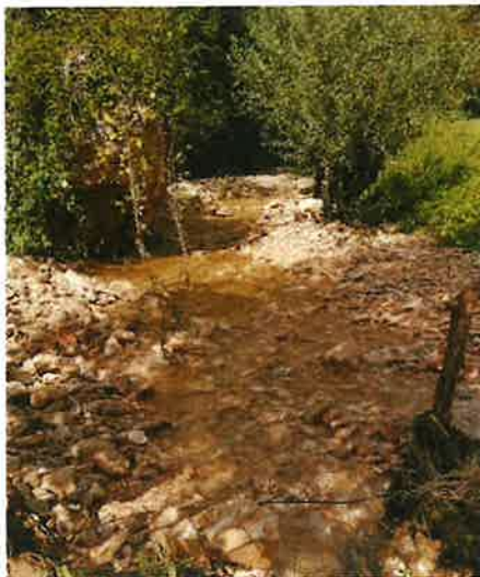
Foto 2 24.09.2024, vista del ramo di sinistra idrografica della Roggia Scandolara verso monte che evidenzia abbondante materiale detritico ostruente la sezione idraulica.
