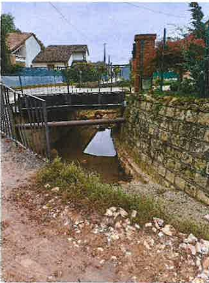
Foto 4 24.09.2024, vista della sezione idraulica in ingresso al canale lungo via Degora a valle del guado.
