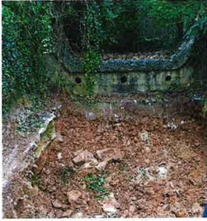
Foto 5 08.10.2024, fase di cantiere, vista della briglia e del fondo a valle della stessa, in fase di risistemazione.
