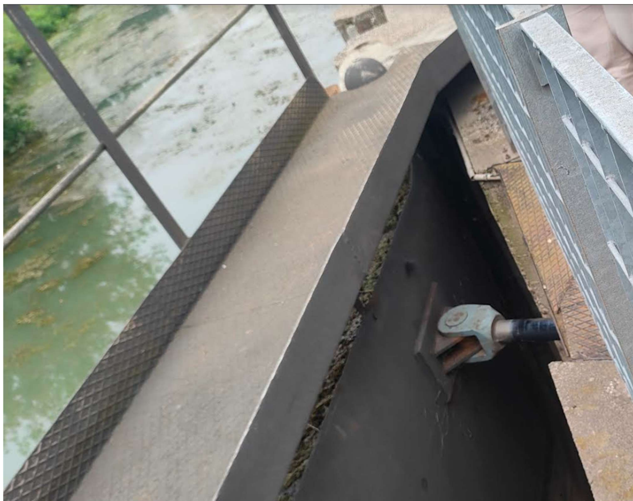
Figura 5 – Cilindri oleodinamici per movimentazione porte vinciane del Sostegno di San Gregorio.
