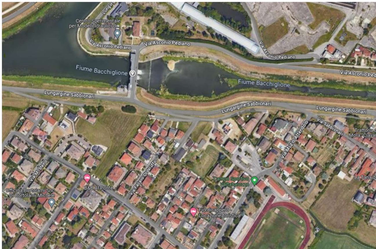
Figura 6 – Ubicazione Sostegno Regolatore in loc. Voltabarozzo di Padova.
