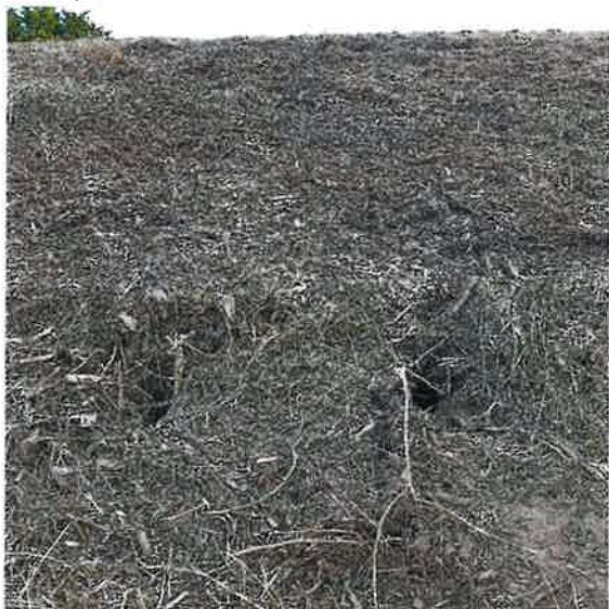
Argine destro – lato campagna a monte del Sostegno Brancaglia (comune di Este)
