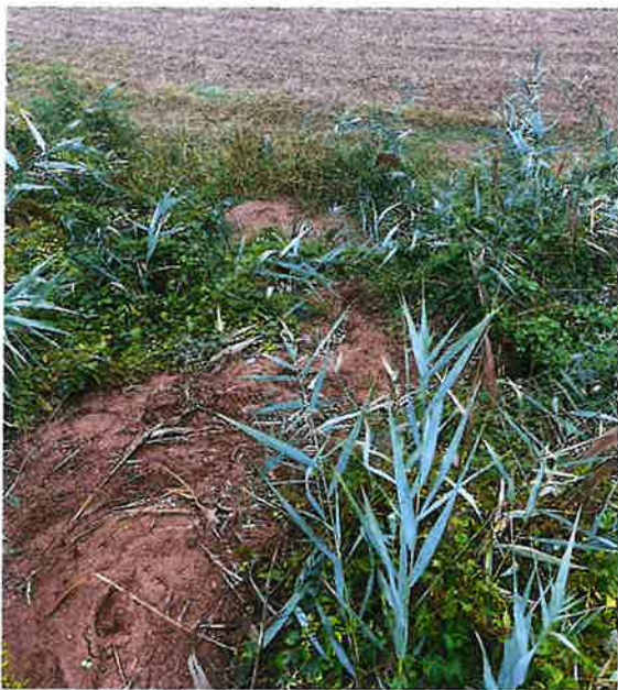
Argine destro – lato campagna a valle della passerella in loc. Santa Croce (comune di Ospedaletto Euganeo)
