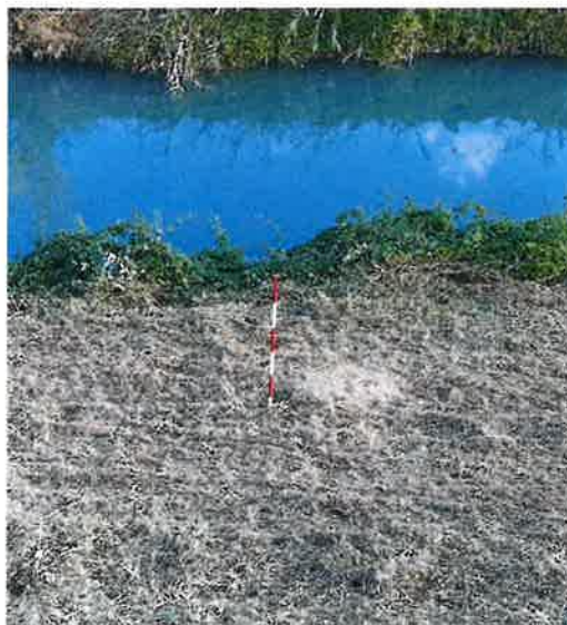
Argine destro – lato fiume a monte del Sostegno Brancaglia (comune di Este)
