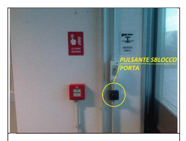
**Figura 1**: Pulsante allarme incendio e pulsante per lo sblocco della porta adibita ad uscita di emergenza.
