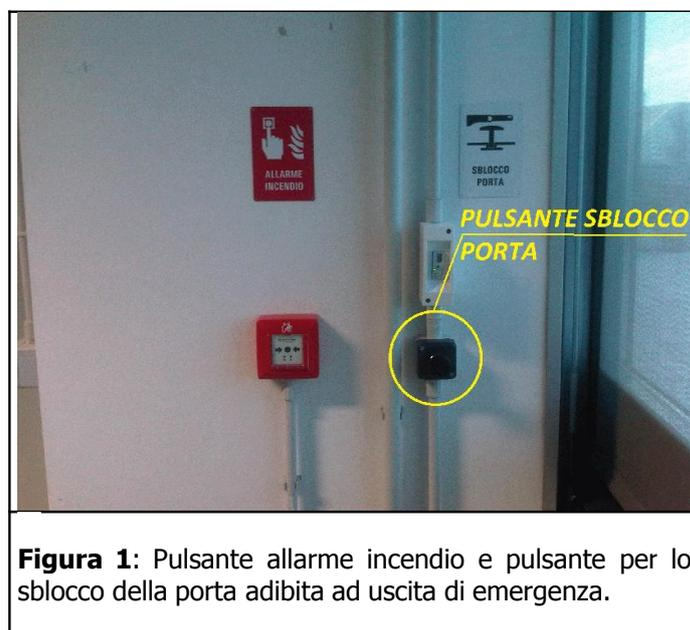
**Figura 1:** Pulsante allarme incendio e pulsante per lo sblocco della porta adibita ad uscita di emergenza.
